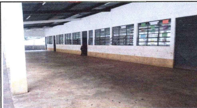
Foto 3: sustitucion de piso a ceramico
