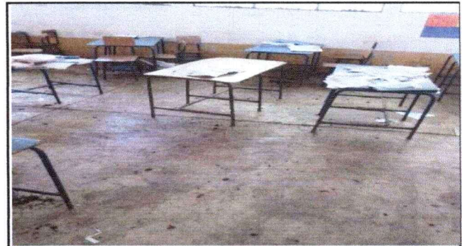
Foto 4: sustitucion de piso dentro de las aulas.
