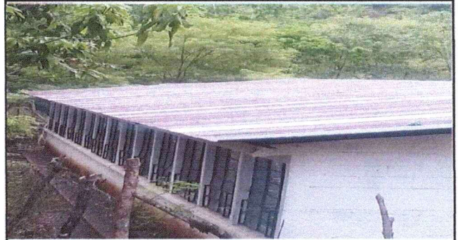
Foto 2: cambio de laminas por troquelada c. 26
